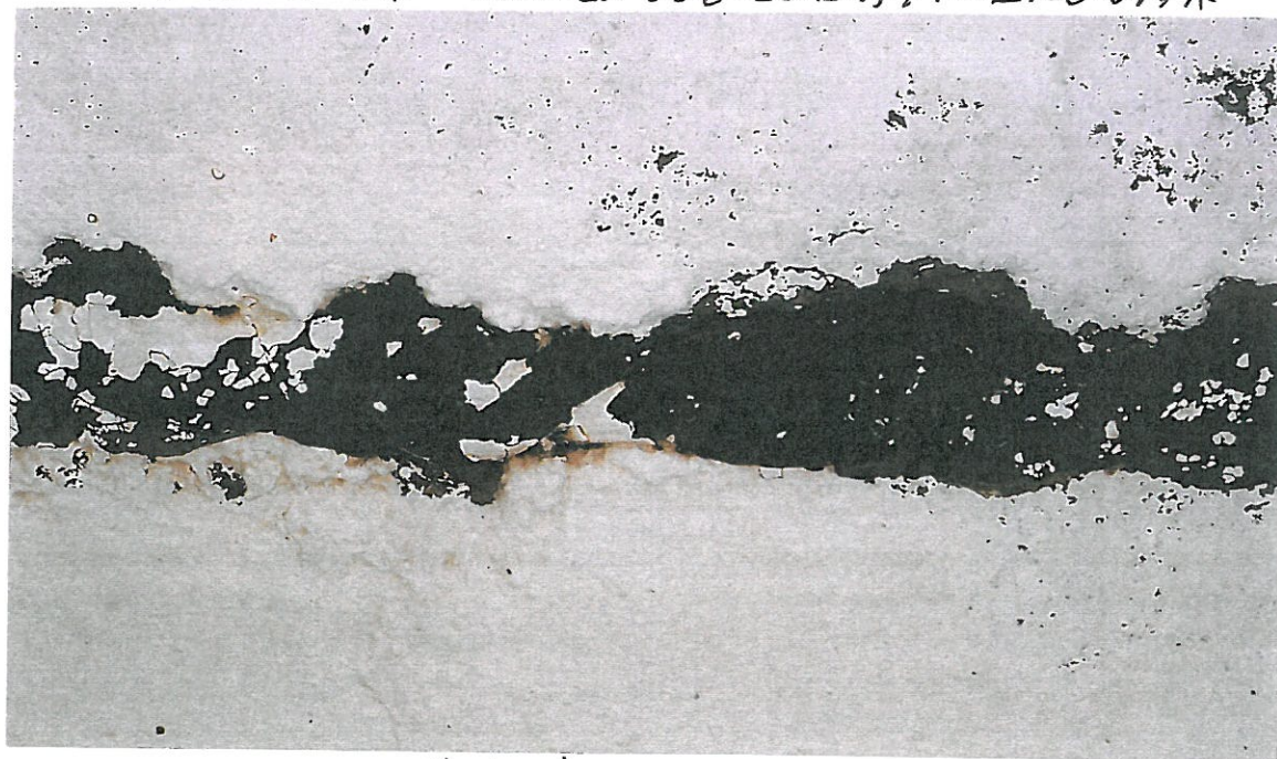
DYLATAcja - BARDZO SZEROKA, NIERÓWNA
