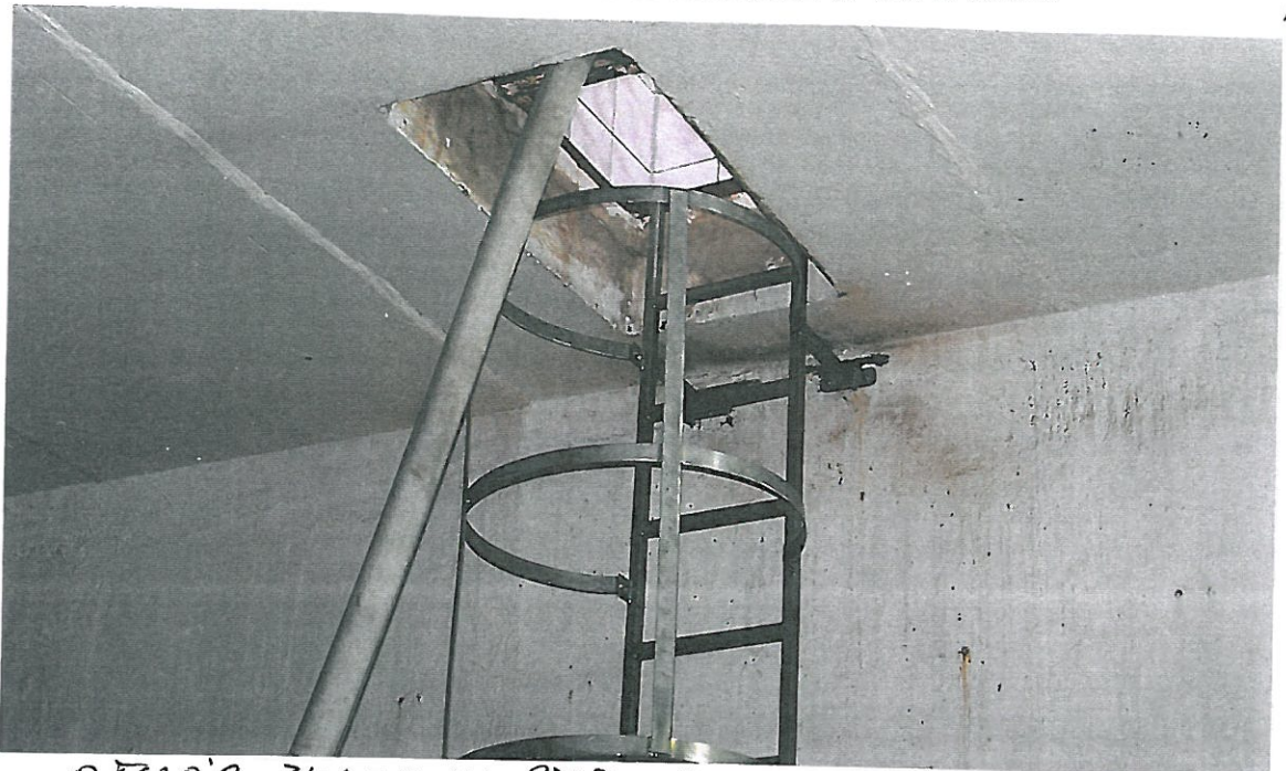
OTWÓR ŻELAZOWY - RDZENIEJĄCA RAMA
