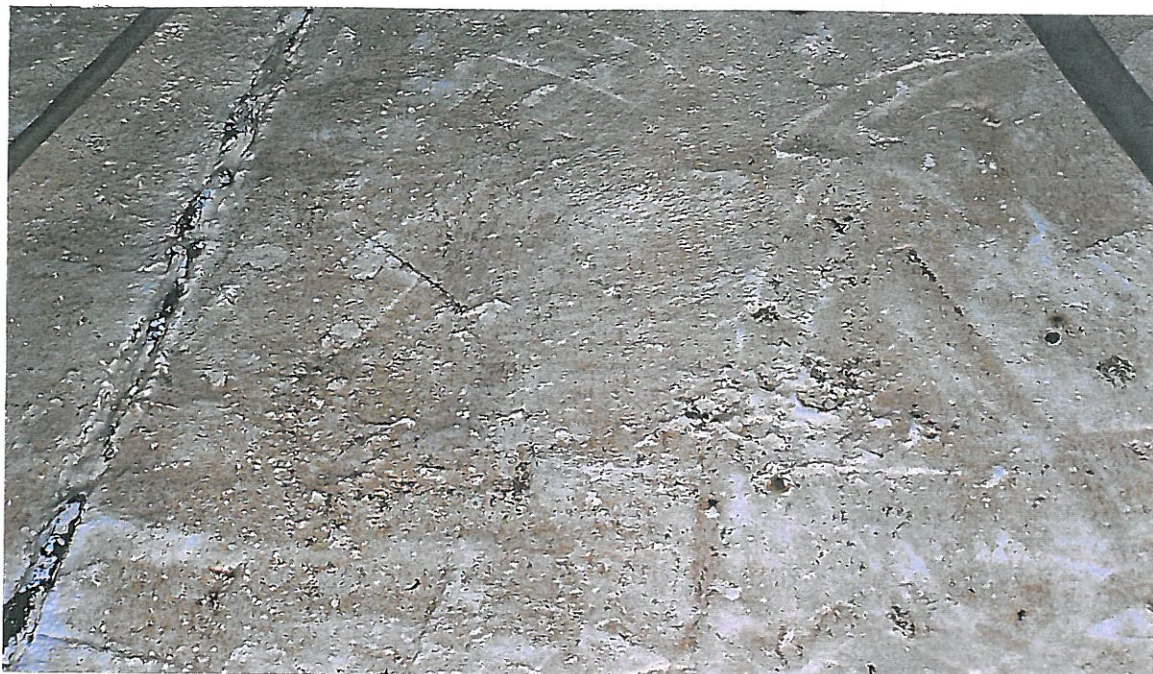
BARDZO NIERÓWNA POW. SKOŚCOW, ZACIERANA ŁOPATĄ, DYLATACE SZEROKIE, BARDZO NIERÓWNE
