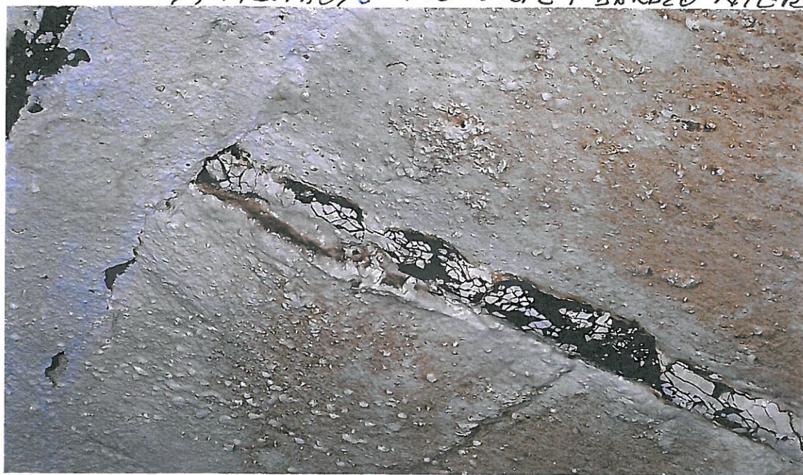
DYLATAcja - BARDZO SZEROKA, NIERÓWNA
