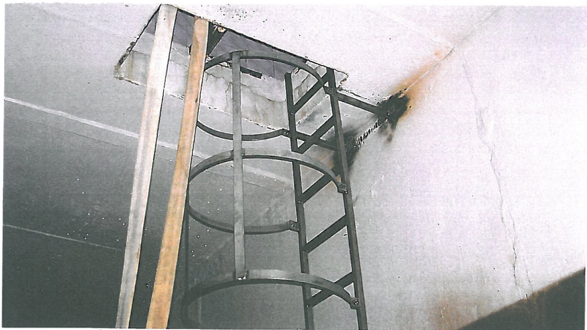
STYK ŚCIANY, DRABINA; RDZEWIĄCIE RAMA OTWORU ZŁĄCZENIA.
