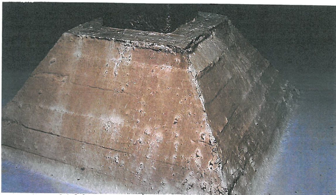
BARDZO NIERÓWNA POWIERZCHNIA BETONU STĘP.
