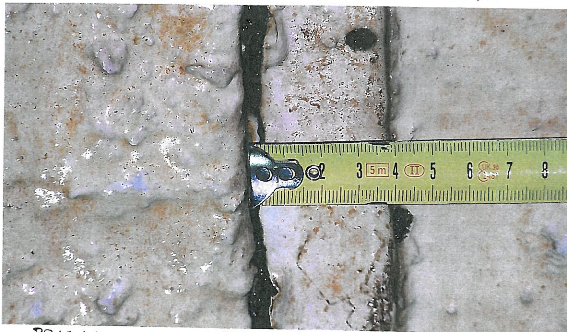
POMIAR szerokości uszkodzonej dylatacji
