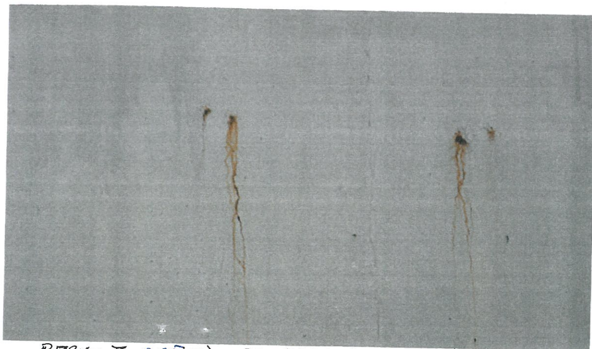
RDZA Z PRÓBNOU PO HAKACH MONTAŻOWYCH
