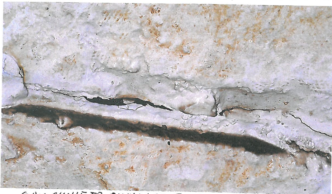
SPUCHNIĘTE DYLATAcjE, Zbyt szerokie
