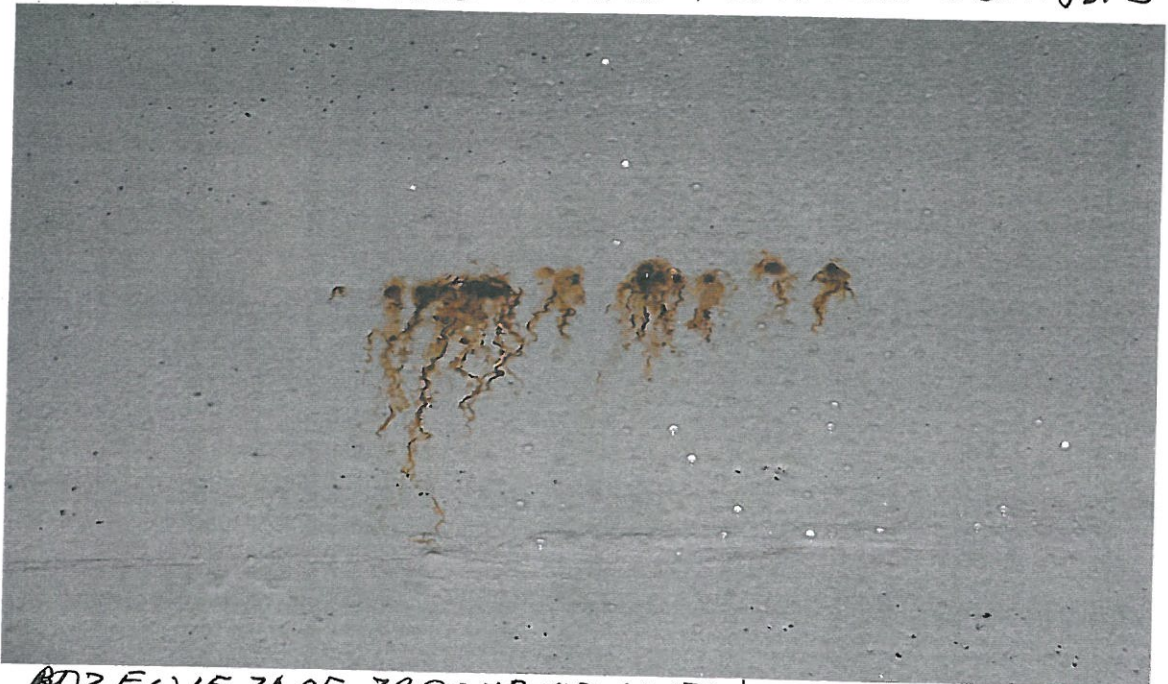
WYCIEKI RDZY I RDZENIOWANIE P.S. OTWORU WENTYL. 3
